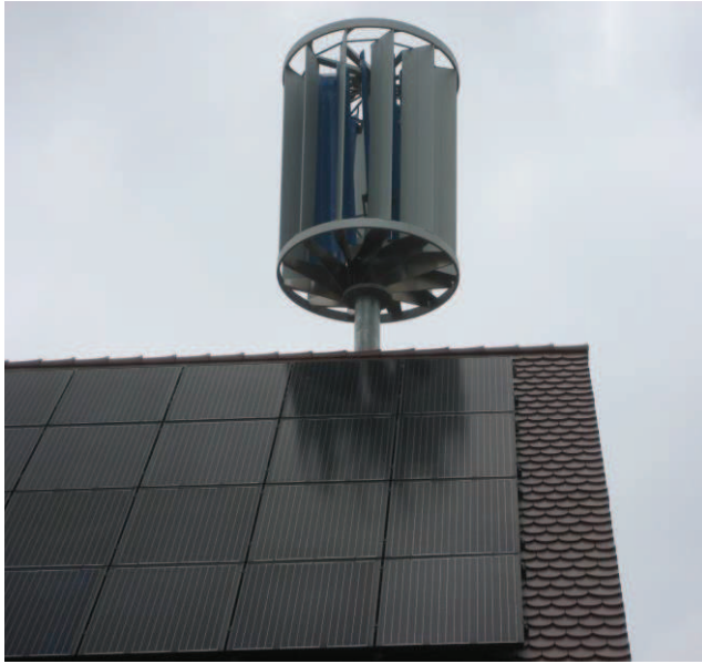
Abb. 1. Installation einer 1 kW Turbina-VAWT auf einem Hausdach.
